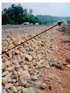
Figura 3 –Vista da Estrutura do Pavimento.
